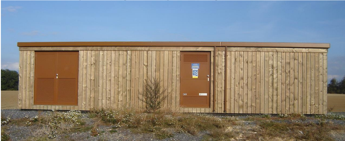
Figure 7 : Exemple de bardage bois sur un poste de livraison
